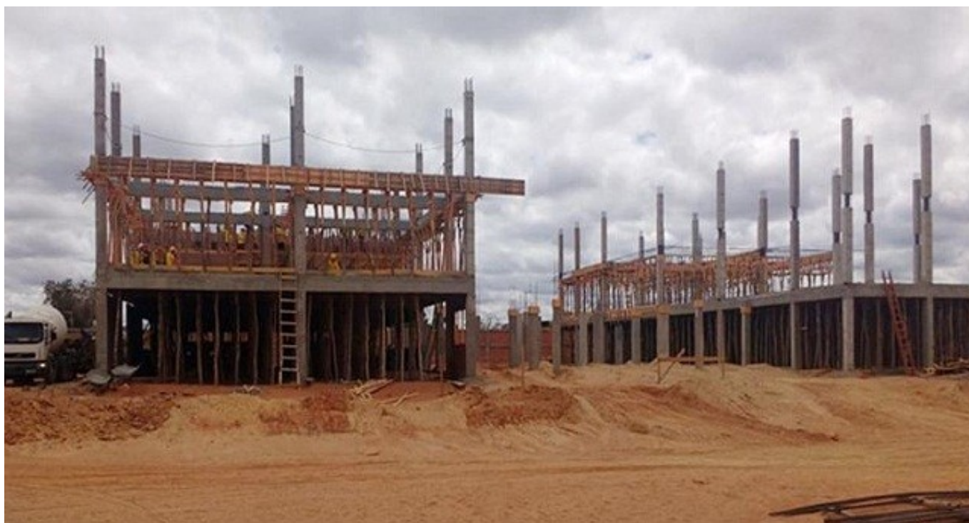
Obras do novo fórum- Foto: Jesika Mayara
