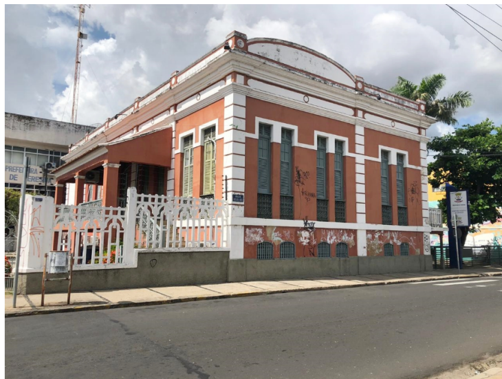
Prédio da Semec
