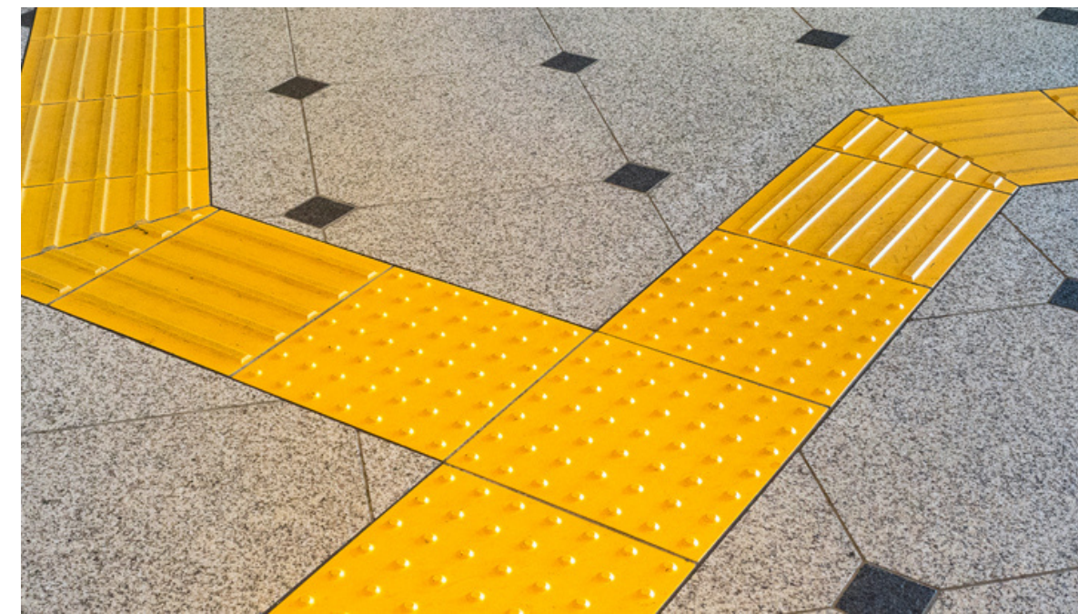
Figura 11- Exemplo piso tátil interno
