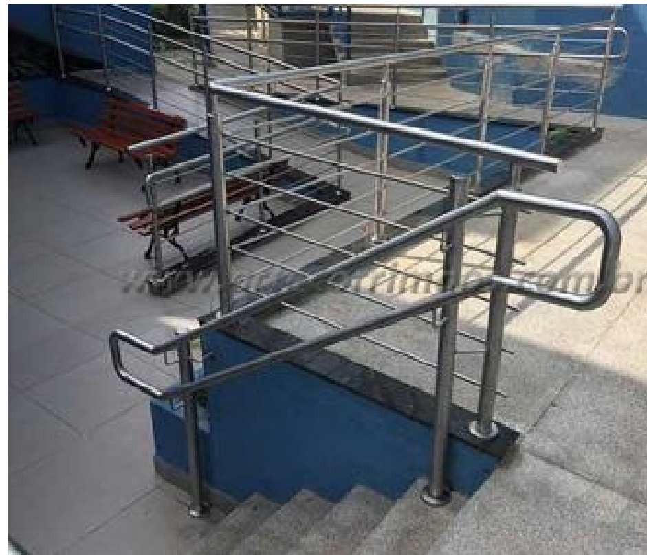
Figura 22- Foto de corrimão para rampa e escada
