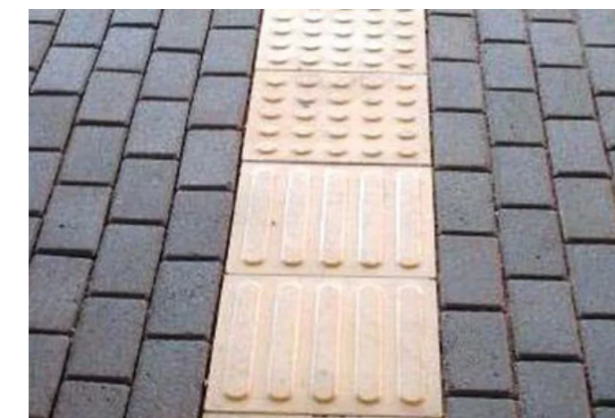
Figura 15- Uso de paver na calçada
